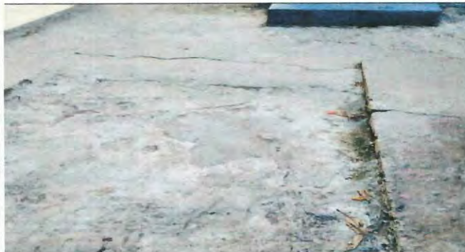
Foto 3: Mejoramiento del entortado mediante la técnica del alisado.
