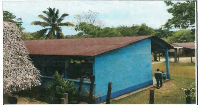
Foto 4: Cambio completo de entechado por deterioro y tiempo de uso: 24 años.
