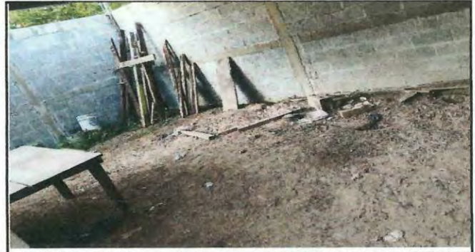
Foto 2: Fundición de concreto en suelo dentro de la cocina escolar.
