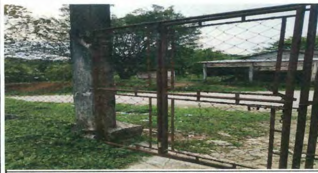
Foto 5: Cambio de portón por deterioro metalúrgico.
